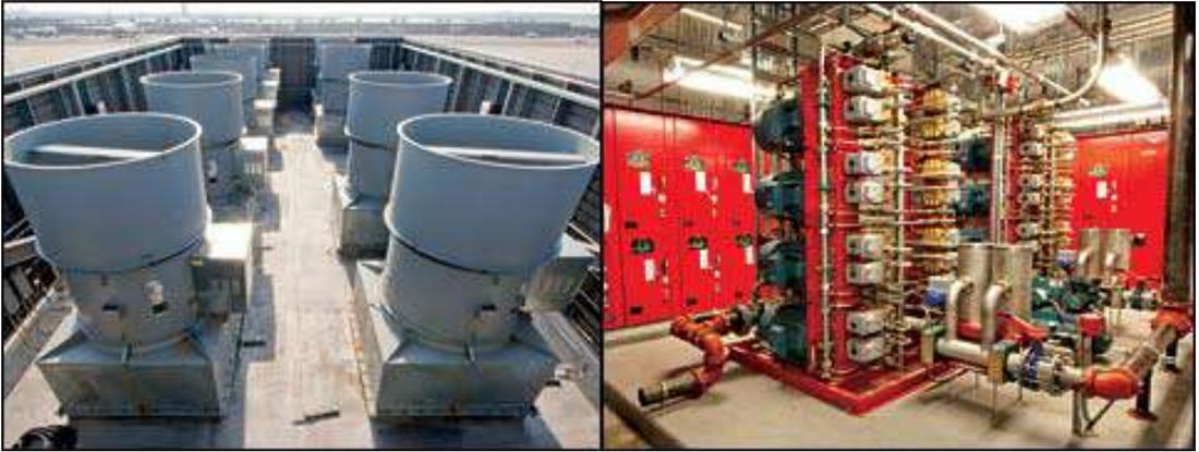
Gambar 6. Sistem ventilasi mekanik sistem hisap transversal untuk pembuangan asap dan sistem pemipaan kebakaran untuk pemadaman di area bawah tanah.
